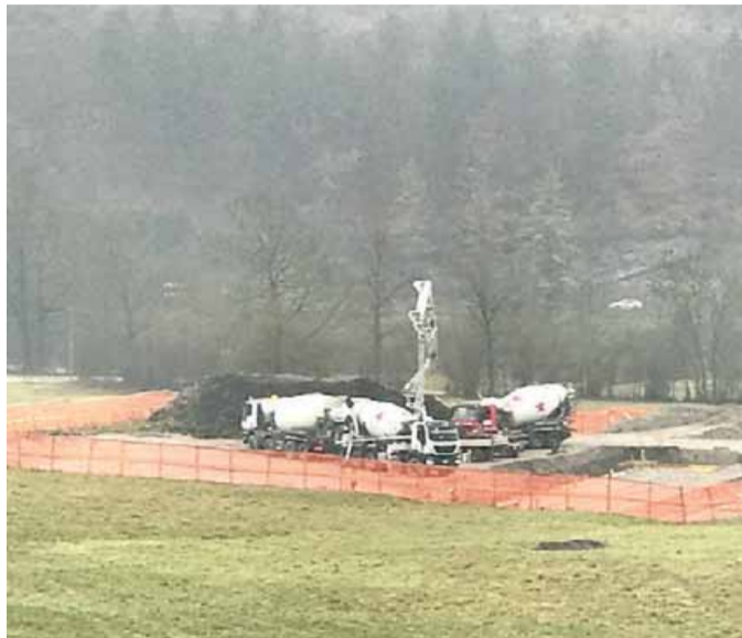
Il cantiere per la realizzazione della contestata stalla di Bezzecca
